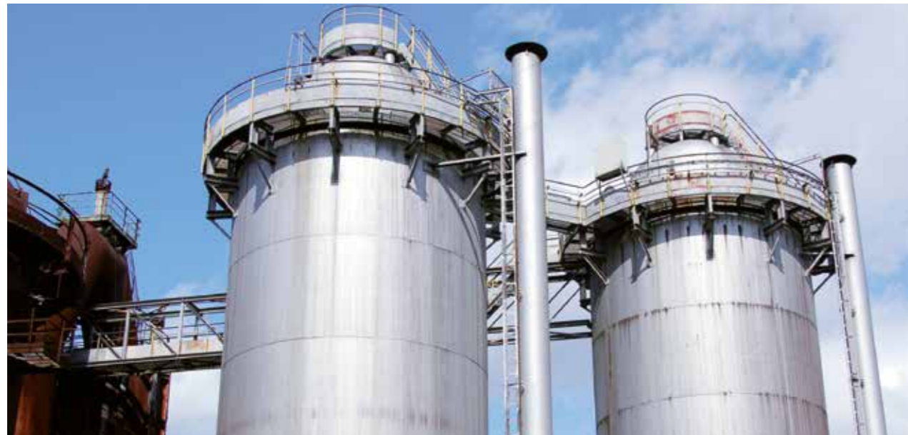
Silo Be- und Entladung
